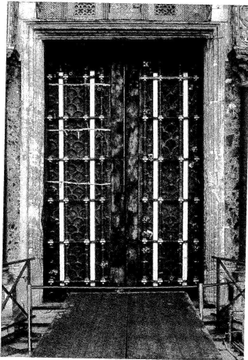
Fig. 1 - Telai in tubi Innocenti montati sulle grate a scopo di rinforzo prima di smontarle.
